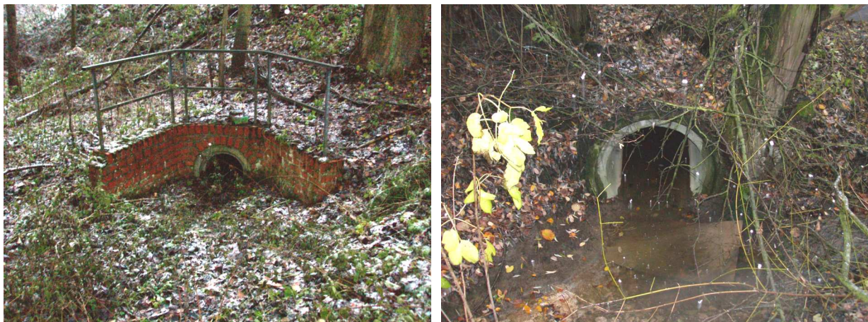
Foto 77: Verrohrungsbeginn Wietholz (V-Rü-8)
