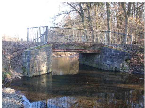
Foto 8: Unterquerung des "Retringer Wegs"
