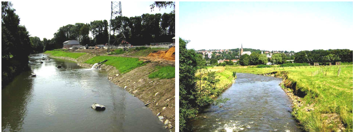
Foto 70: Aufweitung oberhalb Abtissenkamp 2004
