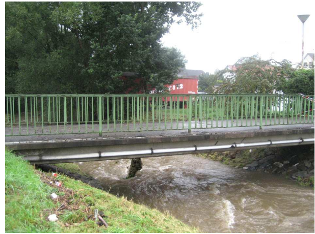
Foto 17: Fußgängerbrücke Walzweg / Fischkuhle
