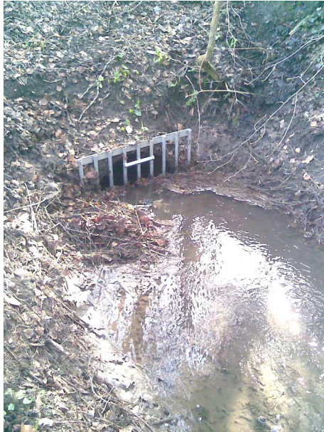
Foto 91: Durchlass „ Neue Straße “
