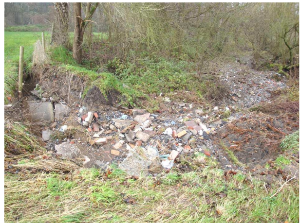
Foto 68: Erosion im Bereich der alten Kläranlage
