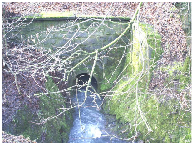
Foto 84: Asbecker Bach - Verrohrung unter Haus
