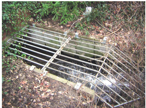
Foto 89: Durchlassgitter "Zum Mühlenteich"
