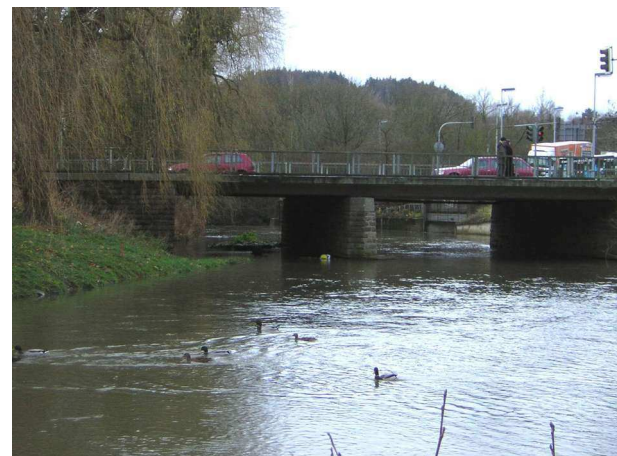
Foto 47: Brücke Iserlohner Landstraße
