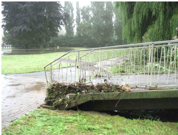
Foto 45: Fußgängerbrücke links August 2007
