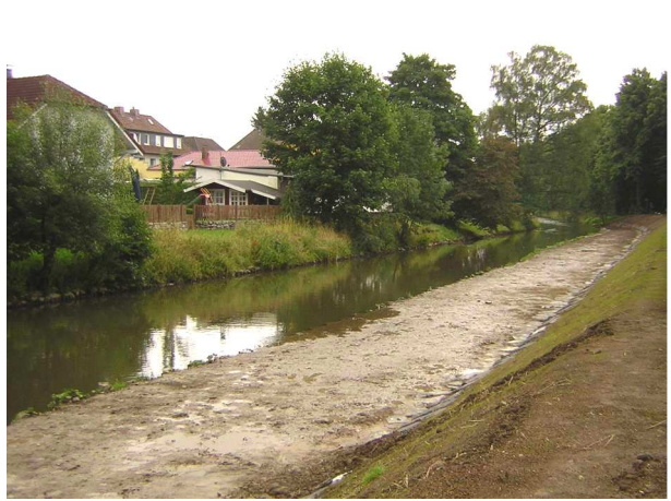
Foto 52: Bereich Daimlerstraße nach Aufweitung 2008
